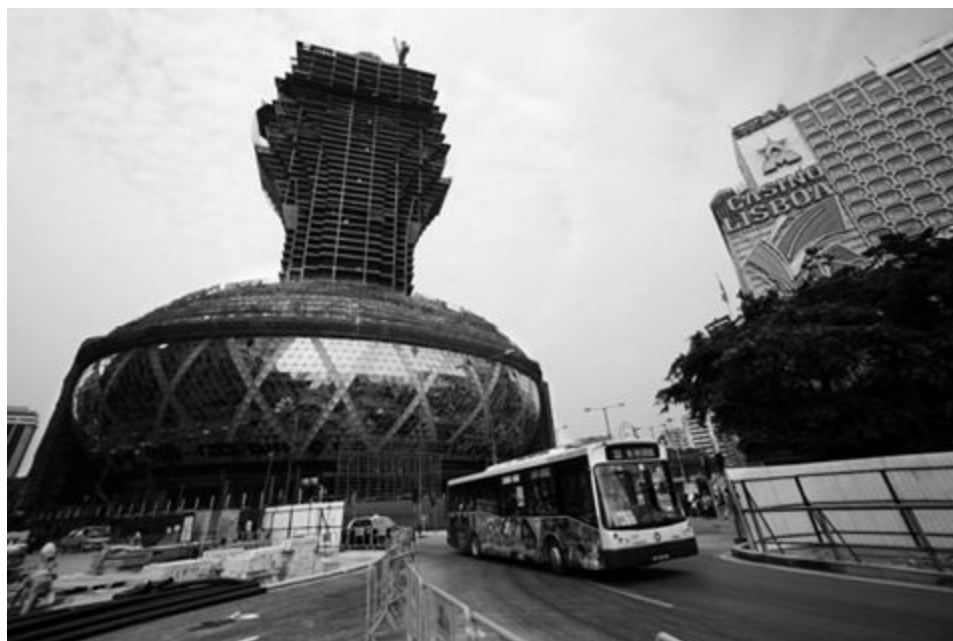
图3 建设中的新葡京赌场酒店 [23]
